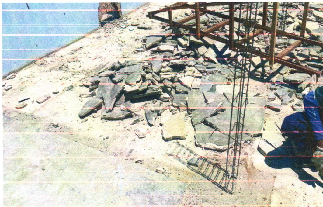
Demolição de Piso Cimentado
