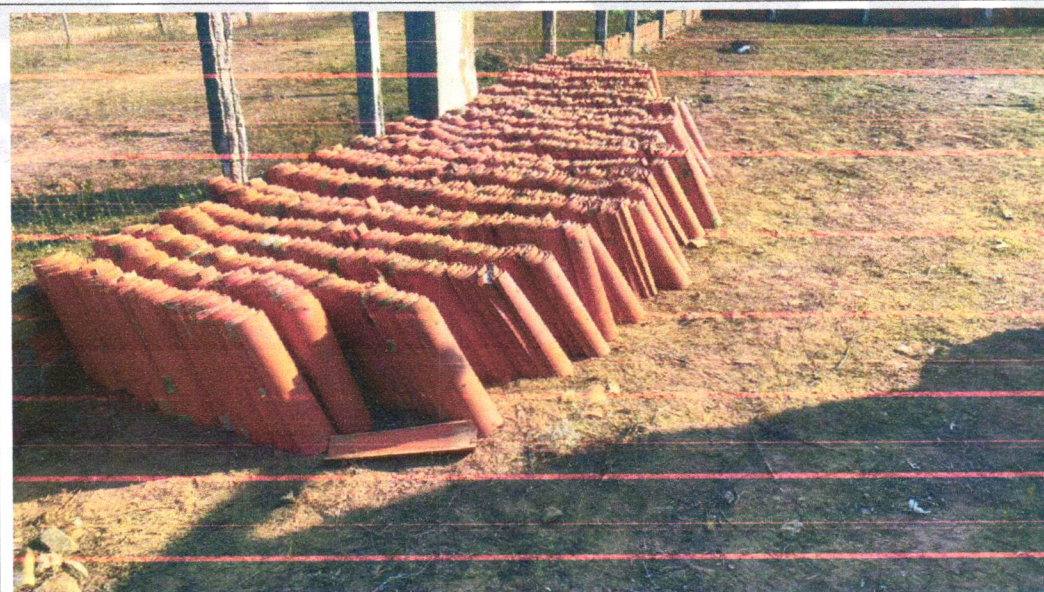
Retirada da estrutura de Telhado
