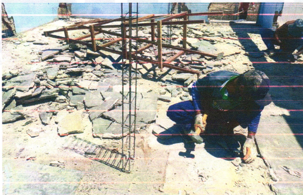
Demolição de Piso Cimentado
