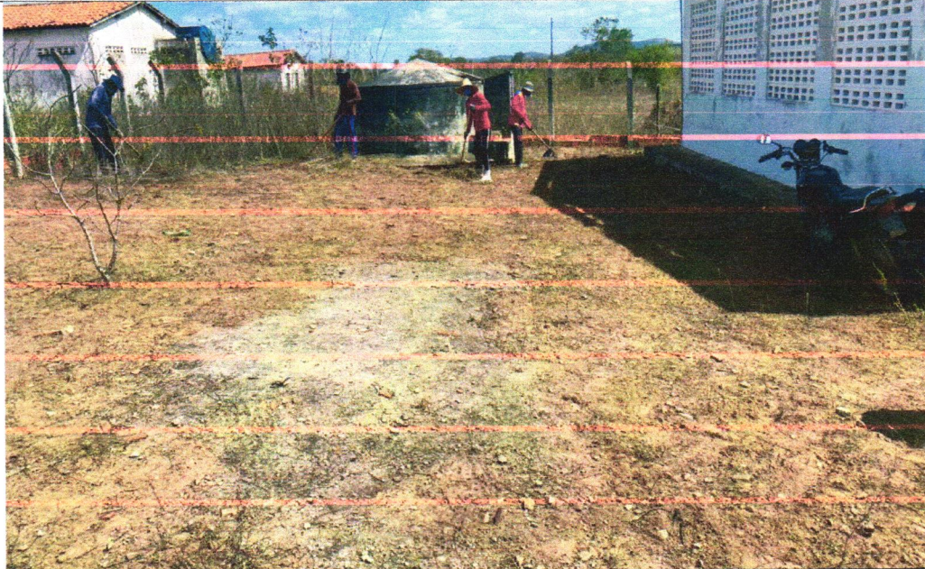
Limpeza manual de terreno com enxada
